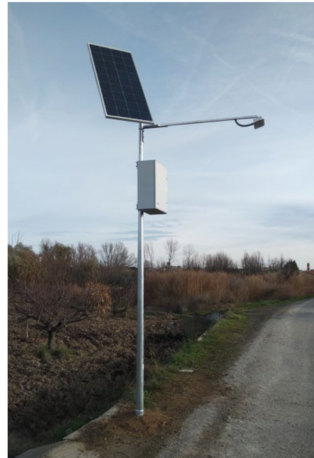
Fitero. Instalación con panel solar
